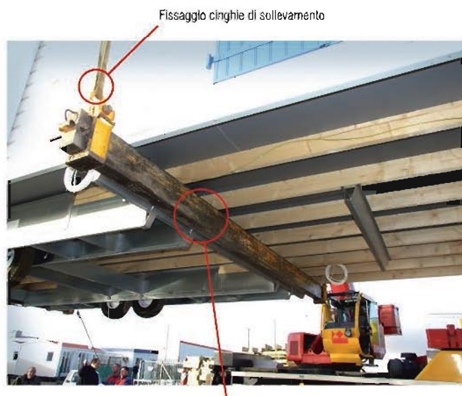
Barra di sollevamento perpendicolare alle armature di sostegno e vicino alla parte centrale metallica
