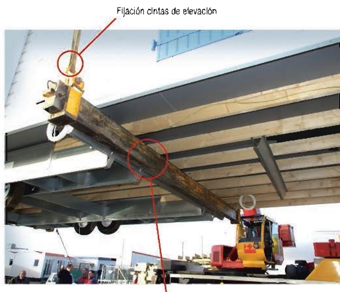
Barra de elevación perpendicular a los listones y cercana a la parte central metálica
